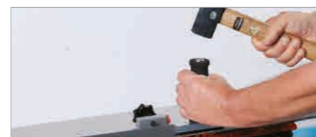
Ausstanzen des beschädigten Belages Punching out the damaged base area Découpez le revêtement endommagé Rimozione della superficie danneggiata
